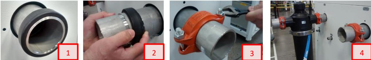
1. Monte o anel de vedação na conexão já instalada no RLAC-S. Utilize detergente neutro para facilitar o encaixe do anel na conexão;
